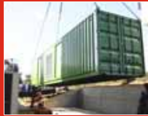
Ernst & Young Wirtschaftsprüfungsgesellschaft Stuttgart 1.000 kVA Notstrom 40" Supersilent-Powerstation zur Absicherung des E/Y zentralen Weltrechenzentrums
