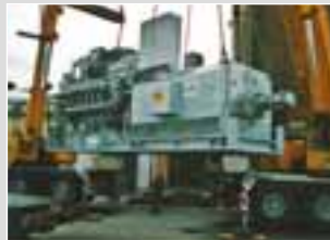
Wieland Werke AG Vöhringen 2 Stück 5.500 kVA Diesel-Notstromaggregat Mittelspannung
