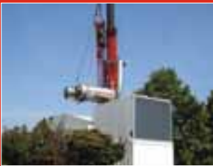
Montage einer Sonder-Abgasanlage mit Schalldämpfern
