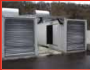
Stadtwerke Schwäbisch Hall 2 Spitzenlast-Aggregate 630 kVA mit MAN und 30" Silent Pack
