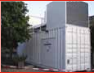
Rechenzentrum Deutsche Leasing Bad Homburg 500 kVA Notstrom 30" Supersilent-Powerstation 45 dB(A)
