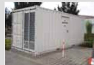
Stuttgarter Rechenzentrum 500 kVA Container Powerstation mit Notstromautomatik
