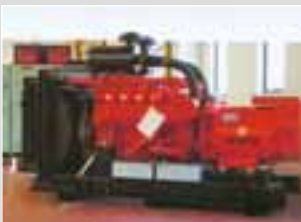
Emscher Genossenschaft Bottrop 1.000 kVA Notstrom- aggregat mit DEUTZ-Motor
